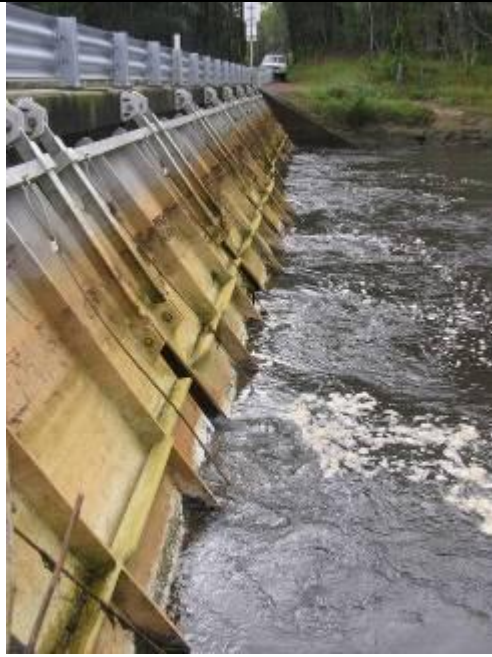
The Baggotville Barrage
